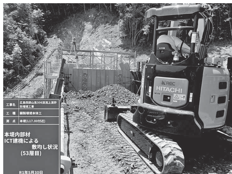
ICT建機による敷均し
